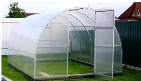
Рис. 1. Арочный тип теплицы из поликарбоната
